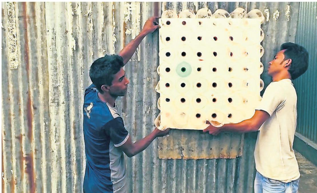
Fabriqué à partir de bouteilles en plastique, Eco-Cooler permet de réduire la température de 5°C, soit autant qu'un climatiseur électrique. DAILY STAR
