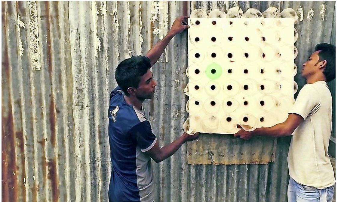
Fabriqué à partir de bouteilles en plastique, Eco-Cooler permet de réduire la température de 5°C, soit autant qu'un climatiseur électrique. DR
